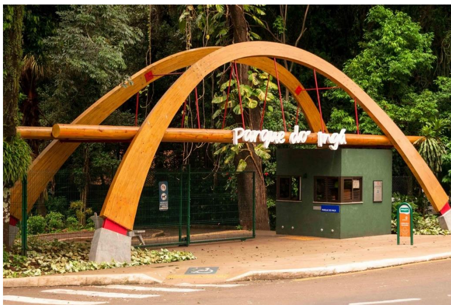
Figura 2.3 – Detalhe de arco de madeira laminada colada
